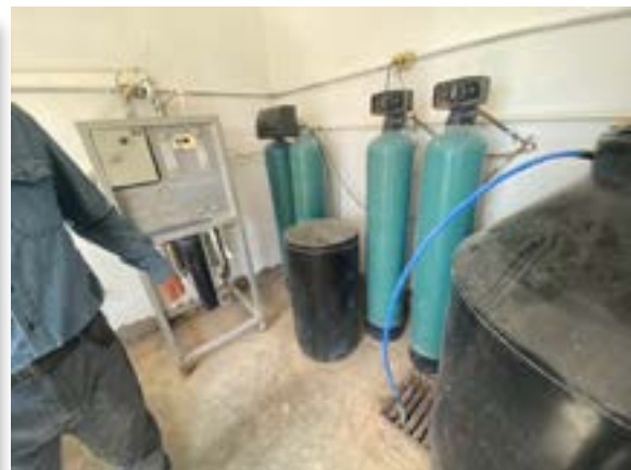
Diagnóstico de la planta purificadora de agua del ejido Granja Morelos, Mapimí, Dgo. Fotografía: Víctor Manuel Salas Aguilar.
