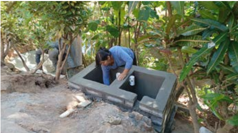
Autoconstrucción del filtro de aguas grises, San Juan Lalana, Oax. Fotografía: Araceli Sanjuan Arteaga.
