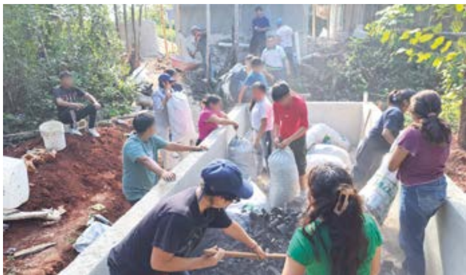
Llenado del Humedal Artificial en el Telebachillerato Comunitario de Yaxley, Felipe Carrillo Puerto, Q. Roo. Fotografía: Karina Gómez.
