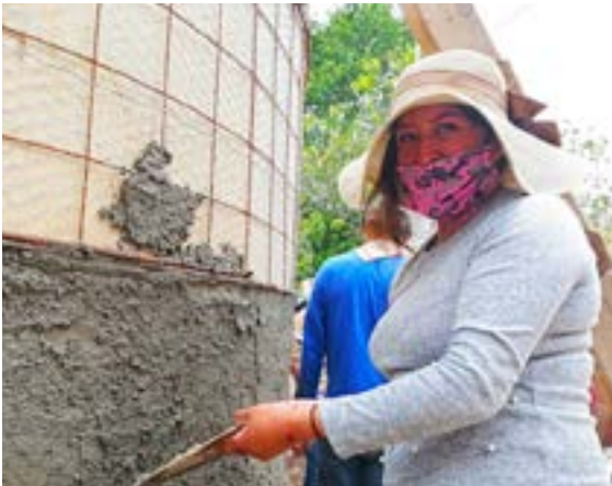
Participación activa de las mujeres en el repellado de cisternas, Metztitlán, Hgo. Fotografía: Construyendo Esperanzas, AC.
