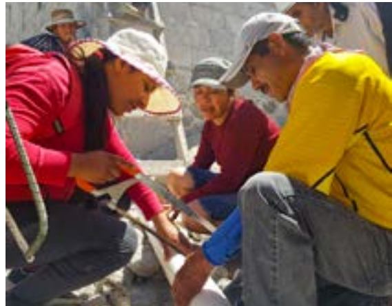
Trabajo colaborativo en la construcción de cisterna, Metztitlán, Hgo. Fotografía: Construyendo Esperanzas, AC.
