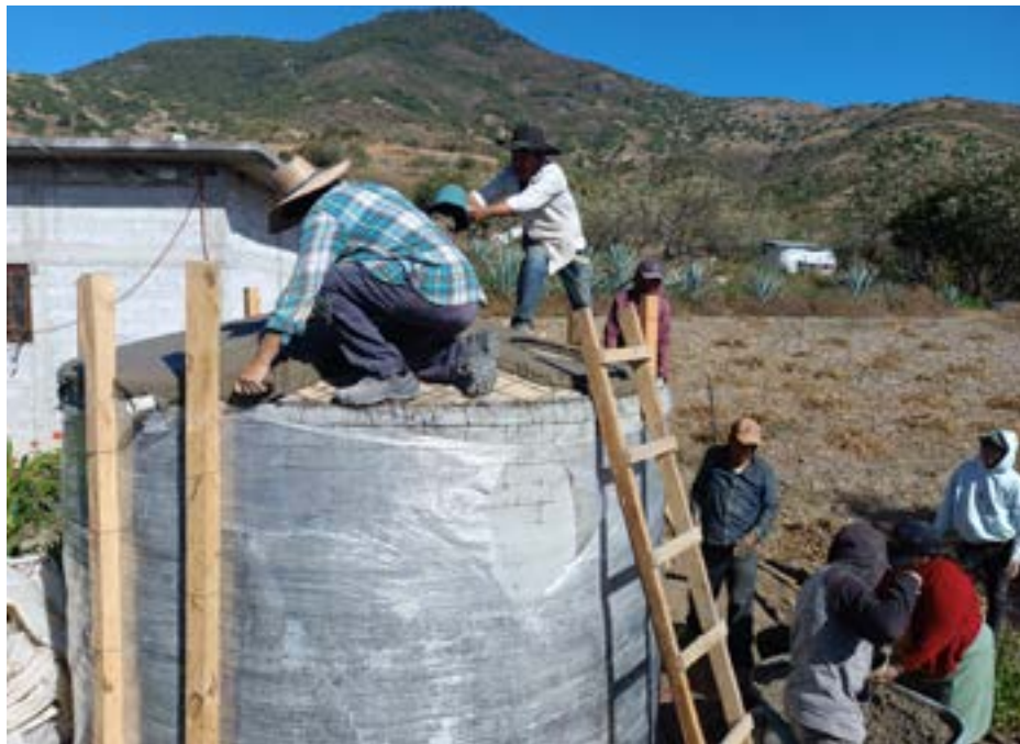
Colado del techo de la cisterna, San Juan Lachigalla, Oax. Fotografía: J. Carlos Vega Carrillo.
