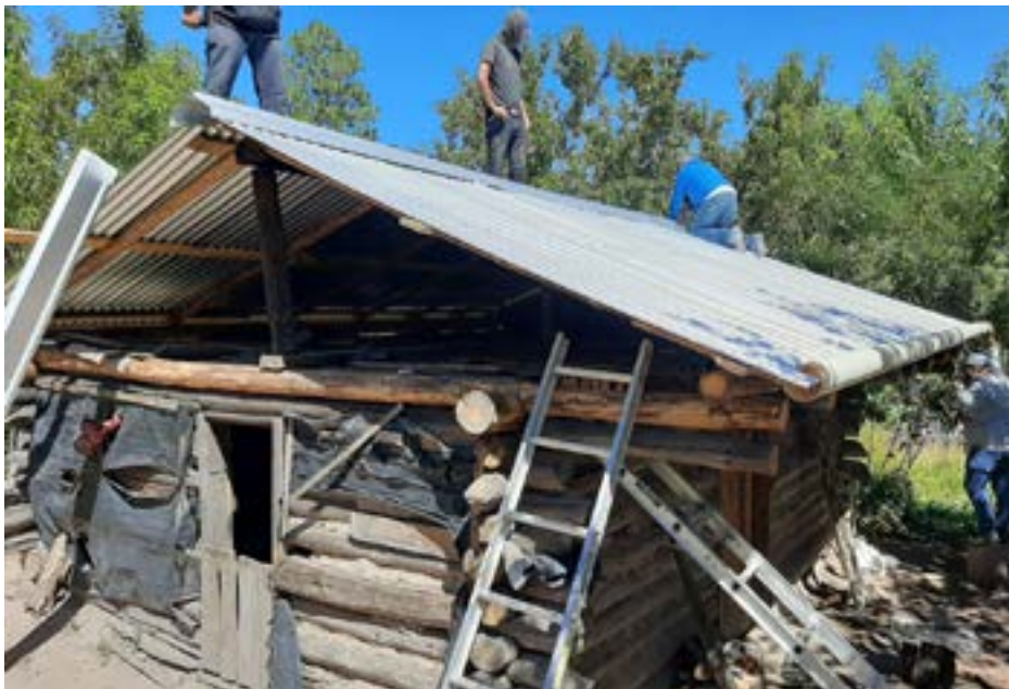
Instalación de sistema de cosecha de agua de lluvia, Creel, Chih. Fotografía: Octavio Robles.
