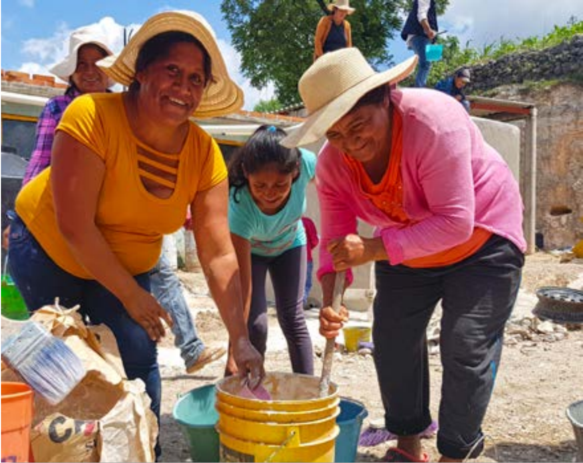
Elaboración de impermeabilizante casero a base de baba de nopal y demás ingredientes de la región, para dar una mayor durabilidad a sus sistemas de captación de agua de lluvia, Metztitlán, Hgo. Fotografía: Construyendo Esperanzas, AC.
