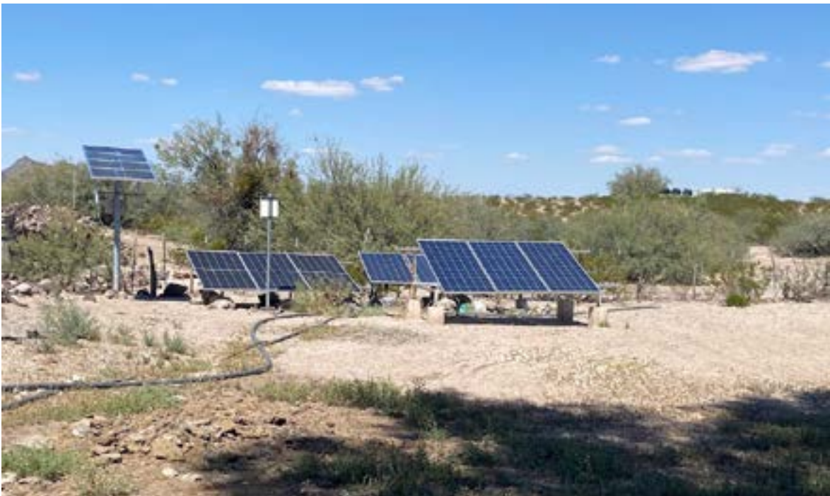
Sistema de bombeo fotovoltaico solar del ejido La Flor, Mapimí, Dgo. Fotografía: Víctor Manuel Salas Aguilar.
