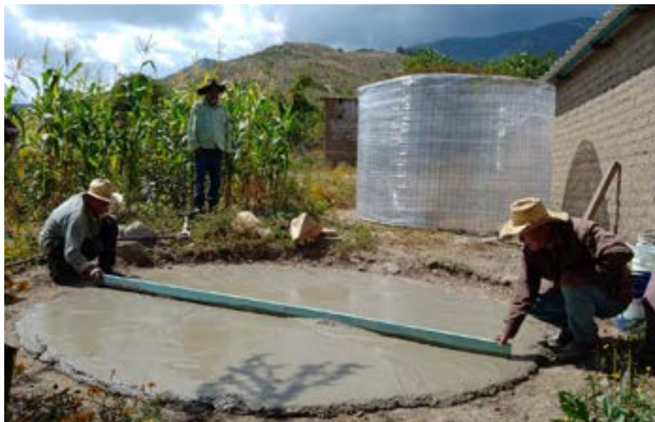
Construcción de la plantilla de cemento que sostendrá la estructura de la cisterna, San Juan Lachigalla, Oax. Fotografía: J. Carlos Vega Carrillo.
